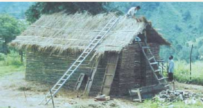
चित्र-2. बांस तथा मिट्टी के उत्पादन कक्ष का कमवार निर्माण
